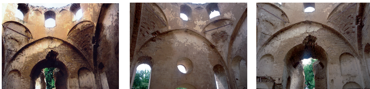
Рис. 2. Фрагмент интерьера церкви Килвар
